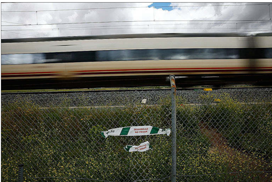
Cinta de «no pasar» de Adif colocada en el PK 92,8 de la vía Madrid-Sevilla. ALBERTO DI LOLLI
